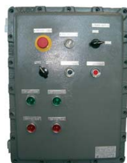
Взрывобезопасная специальная электрическая панель ПУСКА/ОСТАНОВА.
